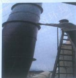
酸性蚀刻液再生循环系统废气排放口
